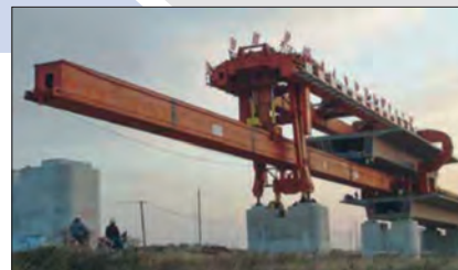
Figura 5A Equipo de lanzamiento Vano entero prefabricado (full span).
