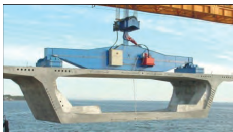
Figura 6B Sección cajón unicelular.
