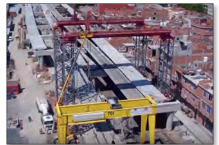
Figura 21A Pórticos de traslación e izaje de vigas.
