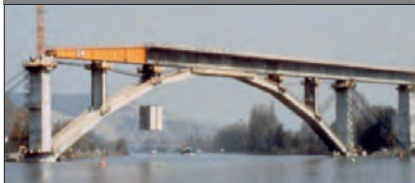
Figura 3B Empuje o Arrastre (incremental launching)
