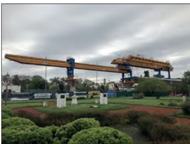
Figura 19A Equipo de montaje articulado y telescópico de auto-lanzamiento de dovelos (articulated single-girder telescopic overhead self-launching gantry crane) a), b) durante el montaje de un tramo.
