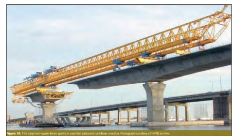
Figura 2B Voladizos balanceados (balanced cantilever).
