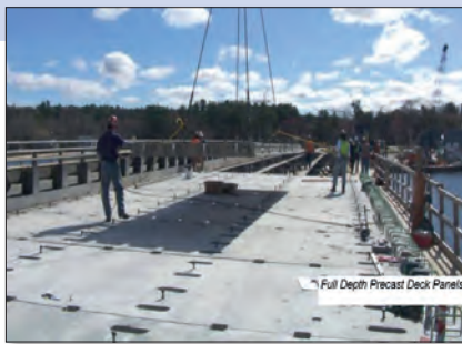
Figura 16A, B y C Paneles premoldeados para losa de tablero (PBES) a), b), c) montaje de paneles
