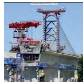
Figura 2B Voladizos balanceados (balanced cantilever).
