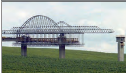
Figura 3C Vano entero in situ con encofrado móvil (Movable scaffolding).
