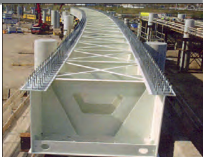
Figura 6D Sección cajón mixta (hormigón - acero).
