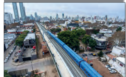
Figura 22B obra terminada.
