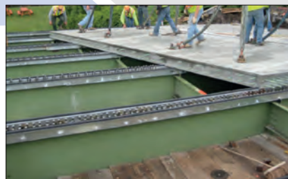
Figura 16A, B y C Paneles premoldeados para losa de tablero (PBES) a), b), c) montaje de paneles
