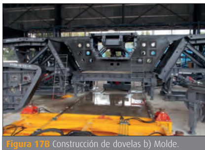
Figura 17B Construcción de dovelas b) Molde.
