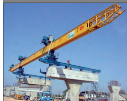
Figura 5C Lanzamiento de vigas prefabricadas (artesa, nabra, I, T, etc.).
