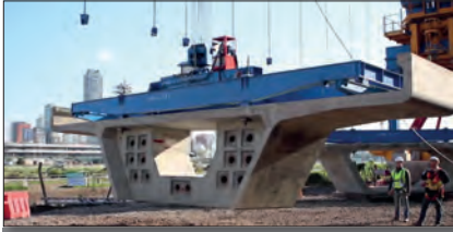
Figura 18A Dovelos de pila - diafragma de anclaje. a) durante su izaje.
