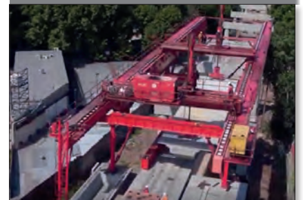
Figura 22A Durante el montaje de una viga cajón.
