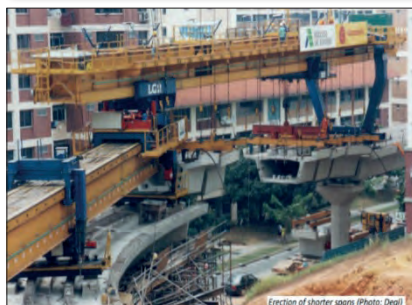
Figura 4A + B Equipos de lanzamiento telescópico articulado de segmentos prefabricados (span by span).
