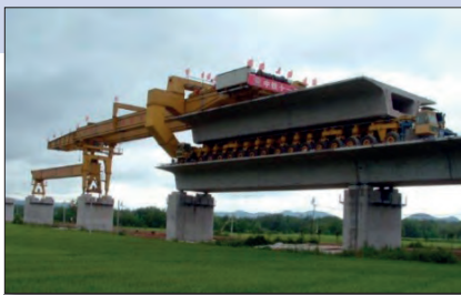
Figura 3A Vano entero prefabricado (full span).
