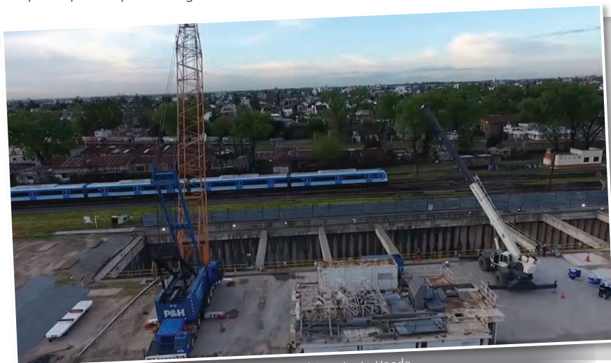
Figura 7: Acceso Obrador Soterramiento Ferrocarril Sarmiento Haedo.
