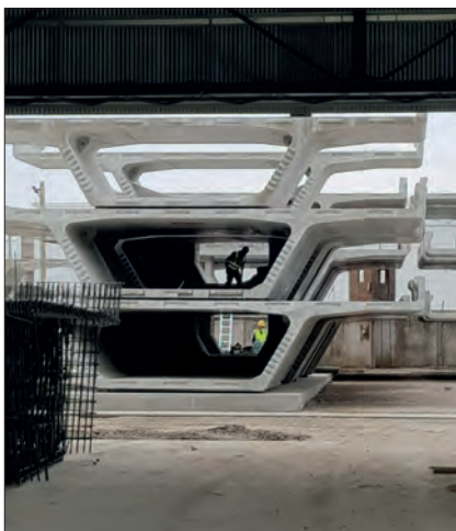
Figura 17A Construcción de dovelas a) Acopio en playa de premoldeados.
