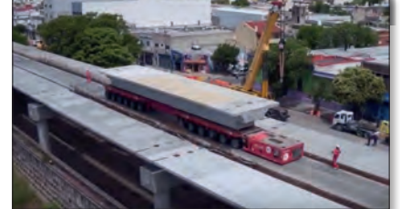
Figura 21A Pórticos de traslación e izaje de vigas.
