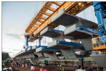
Figura 19A Equipo de montaje articulado y telescópico de auto-lanzamiento de dovelos (articulated single-girder telescopic overhead self-launching gantry crane) a), b) durante el montaje de un tramo.
