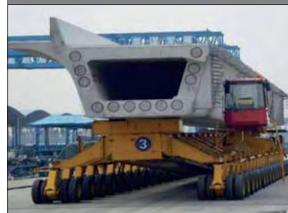
Figura 5B Equipo de transporte Vano entero (full span).
