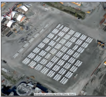
Figura 9A Equipos e instalaciones a) playa de acopio.
