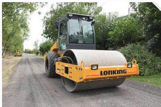
**Figura 1.** Empleo de RAP solo, distribuido con motoniveladora y compactada con rodillo liso en una zona suburbana en el Municipio de Berisso.
