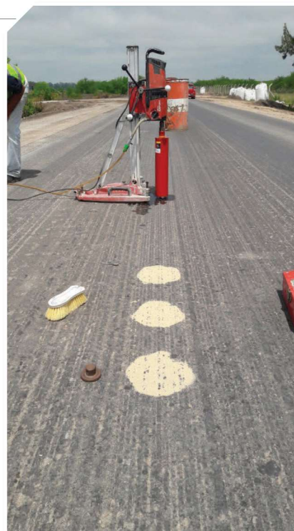
Prueba de campo realizadas en Argentina (Ruta Provincial 215 – Brandsen).
