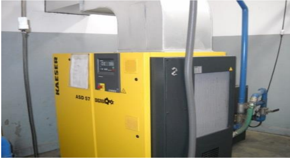
Figura 7- fuente propia. Ídem a foto n°6
