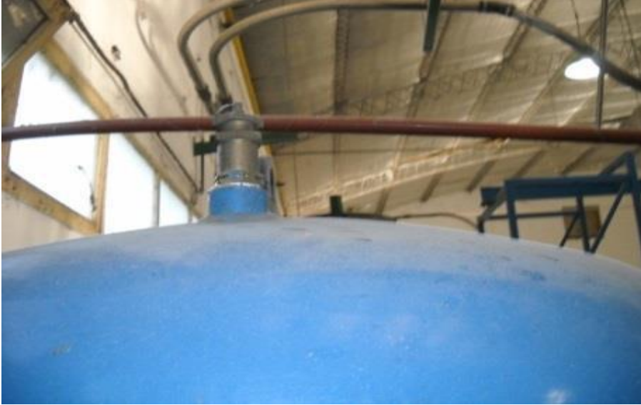
Figura 10- fuente propia. Ídem a foto n°9
