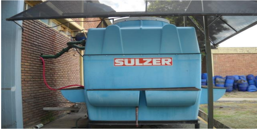
Figura 26- fuente propia. Foto de torre de enfriamiento de agua, para refrigeración de moldes de proceso.
