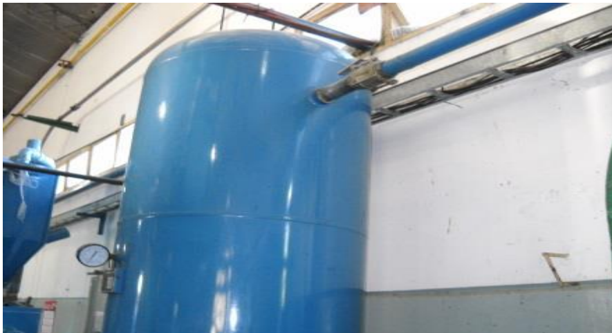
Figura 9- fuente propia. Imagen de pulmón de aire comprimido con llaves de seguridad y Presóstatos.
