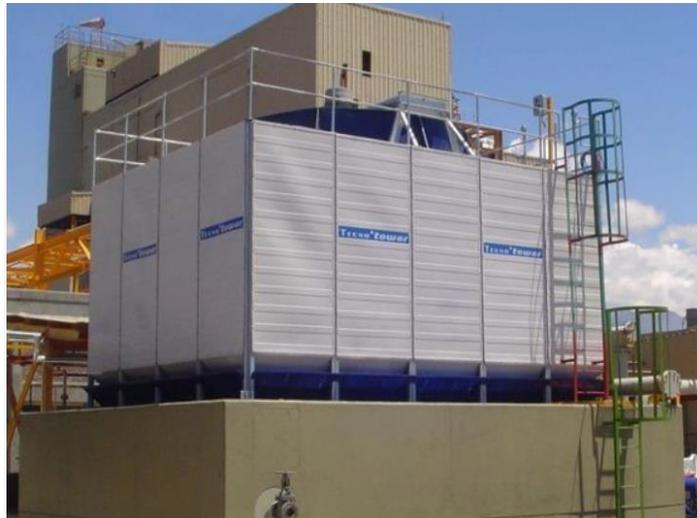
**Figura 36:** Torres de enfriamiento modular Tecno Tower.
