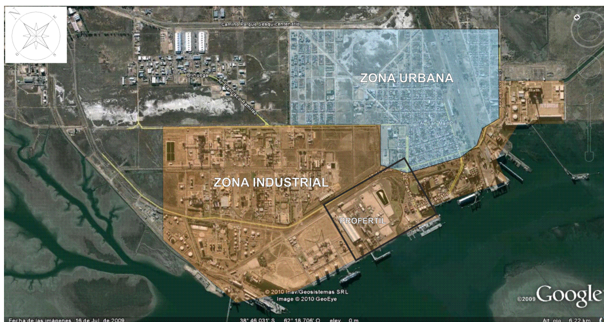
Figura 1. Delimitación de la zona urbana e industrial. La planta PROFERTIL y su área de influencia se encuentra demarcada en la parte inferior.
