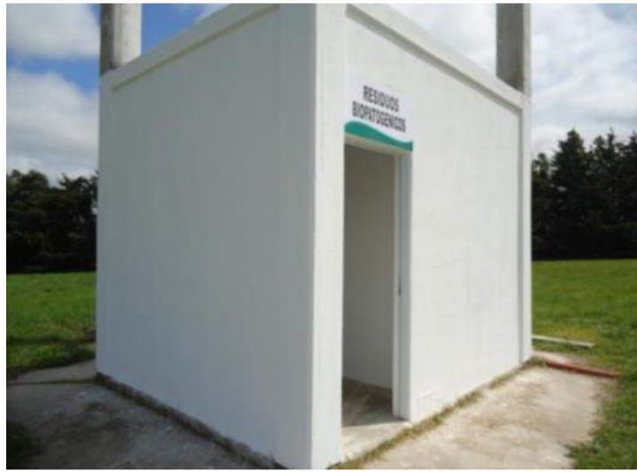
Figura 5 Local de almacenamiento transitorio
