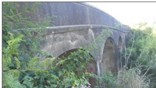
Figura 5 – Fisuras y desplomes en tímpanos.
