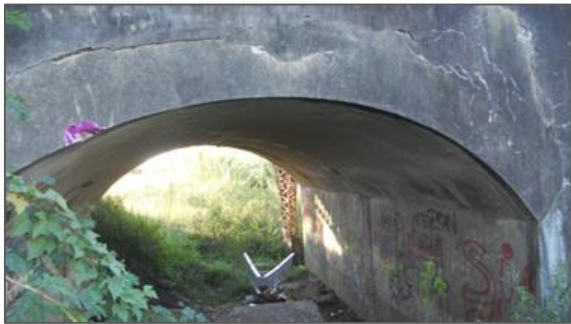
Figura 13 – Fisuras en boquilla, fisura transversal y medición de espesores.
