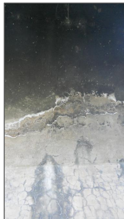
Figura 14 – Fisura longitudinal, ataque biológico y lixiviación en bóvedas.
