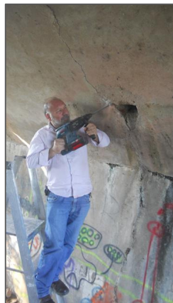
Figura 14 – Fisura longitudinal, ataque biológico y lixiviación en bóvedas.
