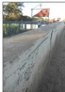
Figura 10 – Fisuras provocadas por el empuje lateral cercano a los estribos.
