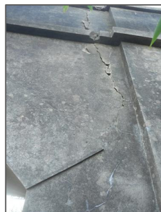
Figura 10 – Fisuras provocadas por el empuje lateral cercano a los estribos.
