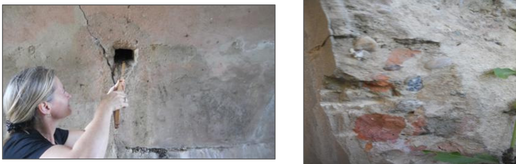
Figura 7 – Medición de desagües y detalles materiales de la bóveda.
