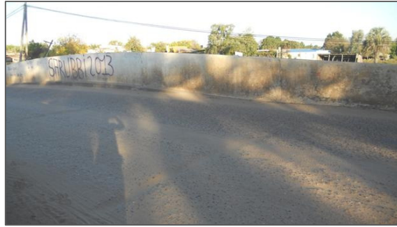
Figura 8 – Vista general de la calzada.
