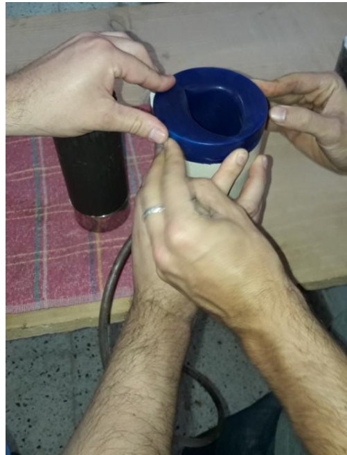
Foto 36. Colocación de la membrana sobre la cupla de PVC
