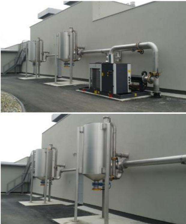
La adsorción química se lleva a cabo utilizando pellets de óxido de hierro como adsorbente.
