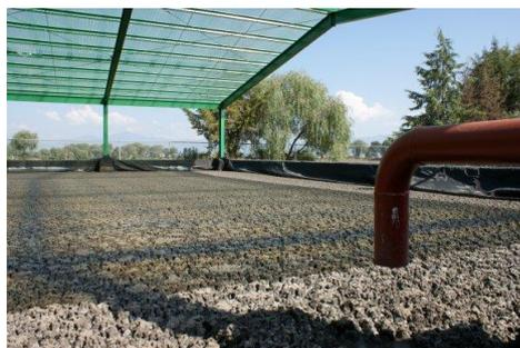
El fondo del lecho es recubierto con tubos perforados que drenan los lixiviados, encima de ellos hay capas de arena y grava que sostienen al lodo y permiten que el líquido se infiltre y sea recolectado por la tubería. Cuando se secan los lodos, se deben separar de la capa de arena para ser desechados, mientras que el efluente recolectado vuelve en parte a la cámara de carga para contribuir en la disolución del material entrante, o bien puede ser utilizada como abono líquido.
