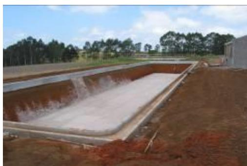
La cámara de digestión se construirá bajo la superficie del terreno con la finalidad de aprovechar el aislamiento térmico natural del suelo.
