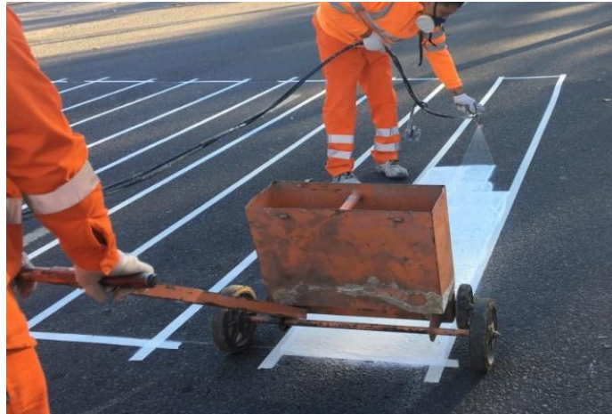
Fig. 1. Aplicación de pintura sobre la senda peatonal según el Método 1
