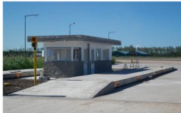
La obra civil es realizada acorde a los planos provistos por SIPEL y consiste en una construcción de simple ejecución basada en fundaciones de hormigón de baja altura. La estructura está conformada por módulos acoplables, de esta manera se reducen los costos de transporte y se elimina el uso de maquinaria pesada para la instalación de la balanza.
