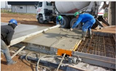
Los módulos se construyen a partir de cabezales en perfiles de acero y parrillas de hierro. Estas parrillas se arman de manera transversal dentro de un encofrado recuperable. Luego el encofrado se rellena con hormigón H 30. El tendido de cañerías para los cables de celda se efectúa previamente, quedando incorporado a los módulos.
