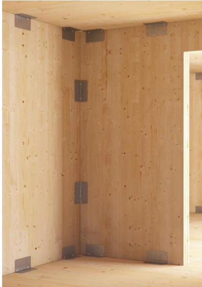
Figura 65: Imagen ilustrativa de utilización de conexión (2) “TITAN N”.
