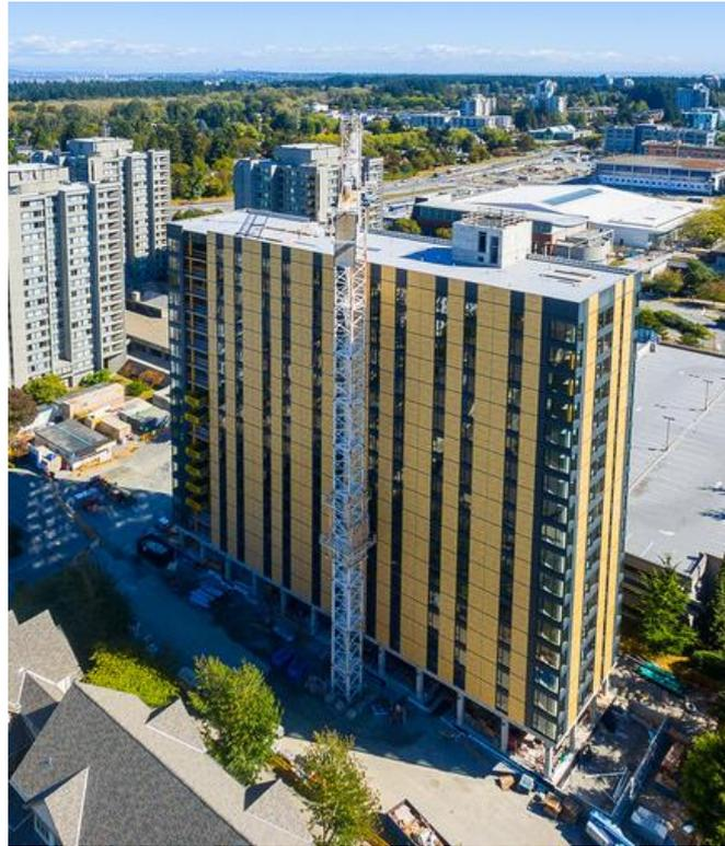
Figura 35: Edificio Brock Commons – Canadá -Estructura en CLT de 18 pisos.
