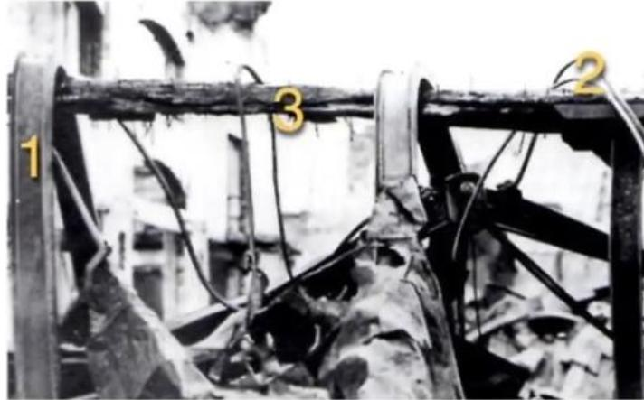
Figura 31: Estructura de madera, hormigón y acero, posterior a la acción del fuego.
