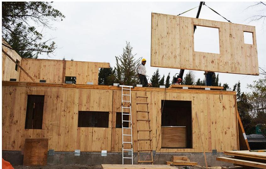
Figura 21: Montaje de estructura de CLT.
