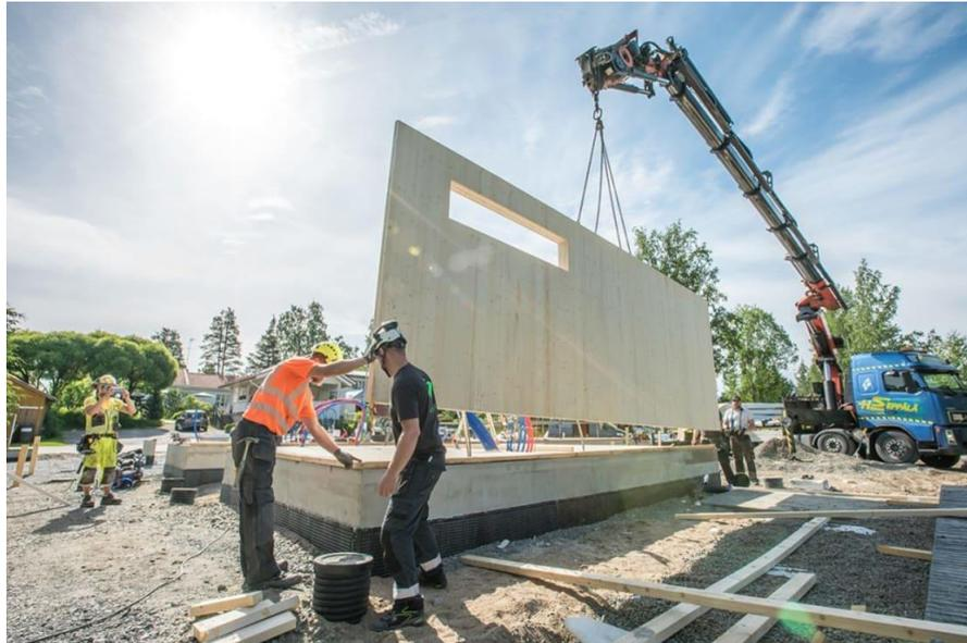
Figura 26: Montaje de panel CLT.
