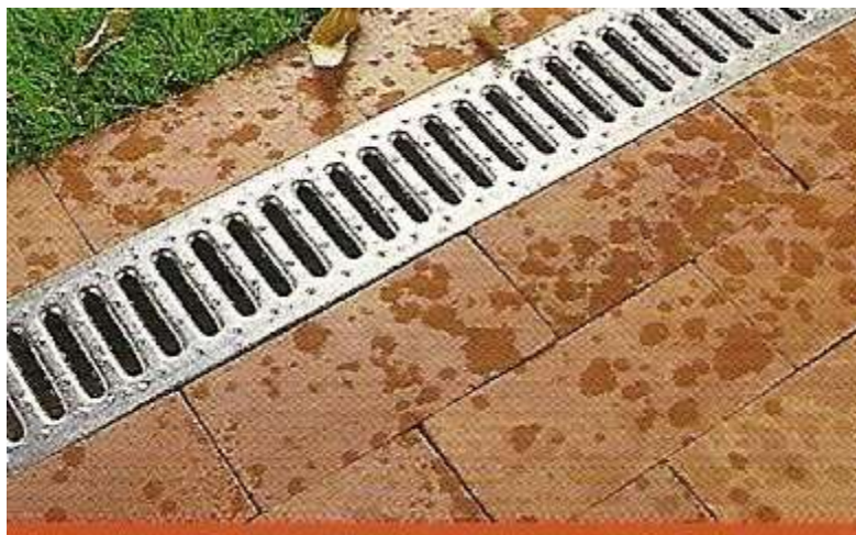
Figura 15 - Albañal pluvial.
