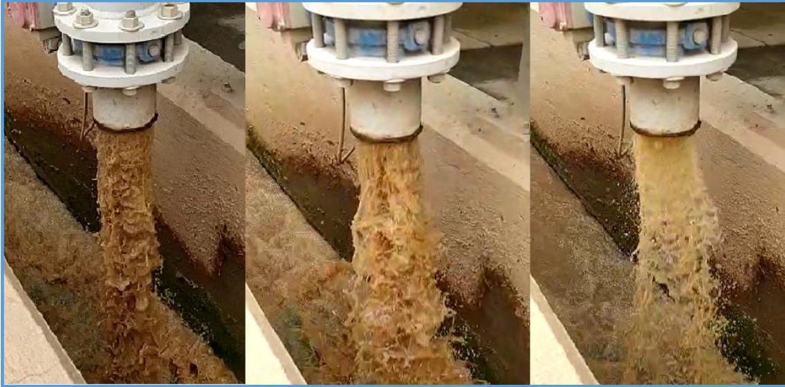
Figura 16 : Purga del barro en diferentes momentos de la descarga
