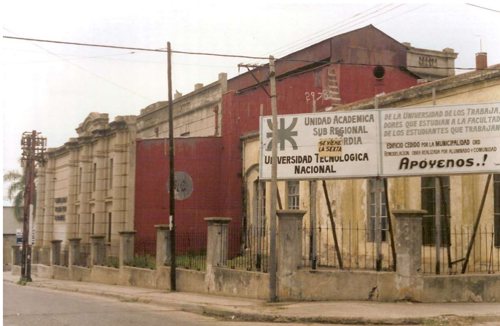
Figura 10 – Vista esquina Calle Salta y San Juan.
