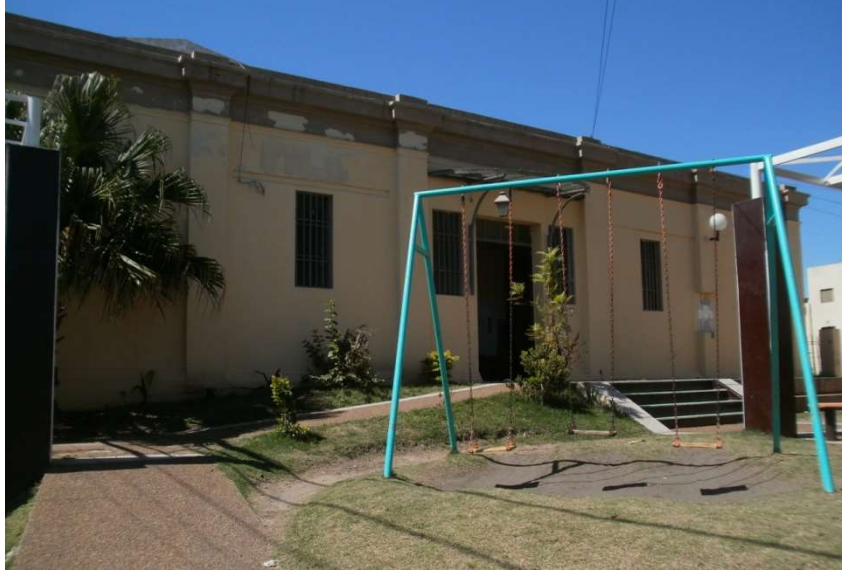
Figura 2 - Edificio Existente correspondiente a las Oficinas de Deportes de la Municipalidad.
