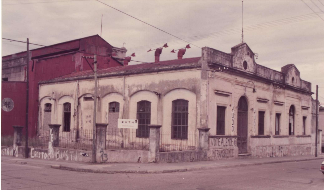
Figura 9 – Vista frontal del edificio en esquina San Juan y Salta.
