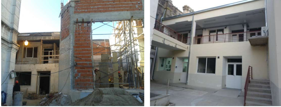
Figura 19 – Obra ampliación de laboratorios y construcción de aulas nuevas.
