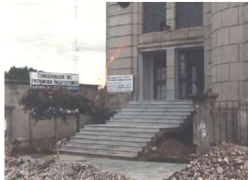
Figura 11 – Habilitación del acceso desde calle Salta
