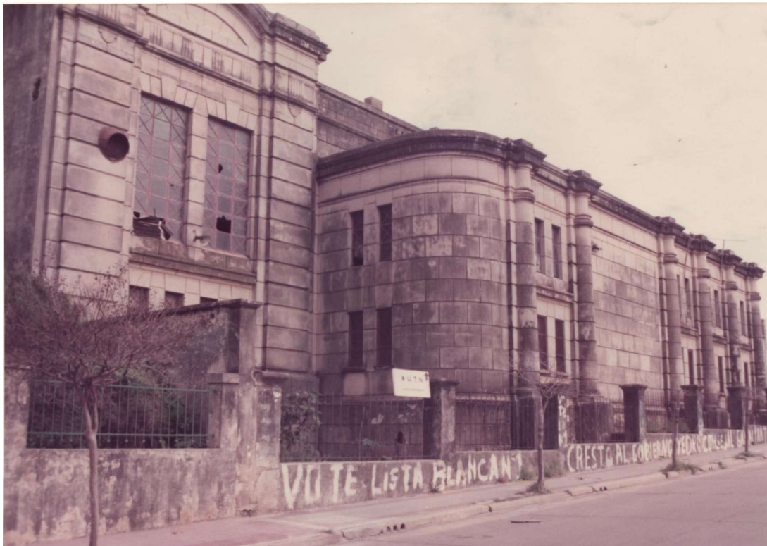
Figura 8 – Vista lateral sobre calle Salta del edificio cedido por la Municipalidad de Concordia.
