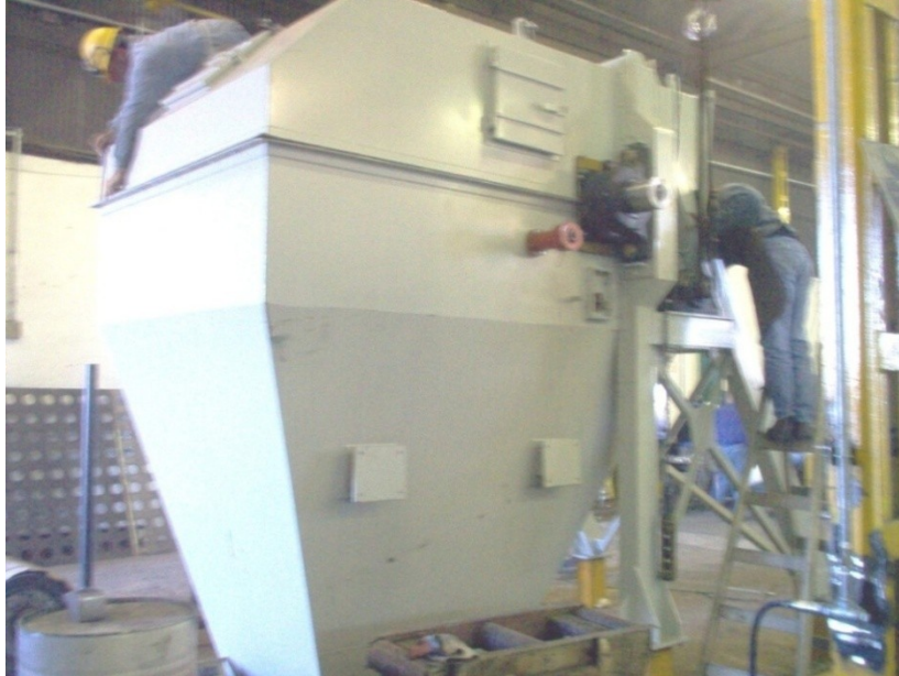
Figura 43: Armado del Cabezal Motriz en Fábrica
