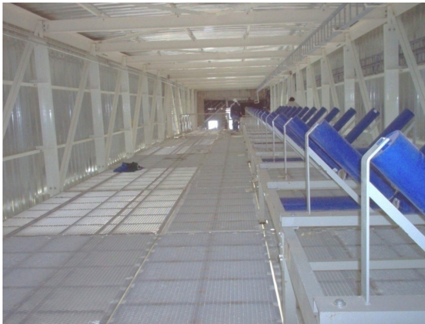
Figura 44: Montaje de cinta en galería
