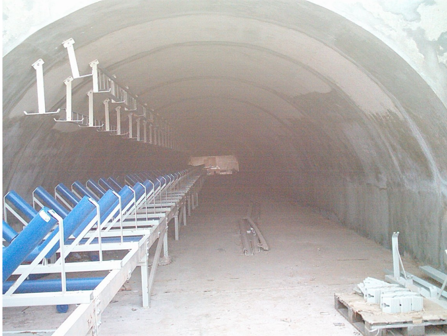
Figura 41: Montaje de cinta en túnel
