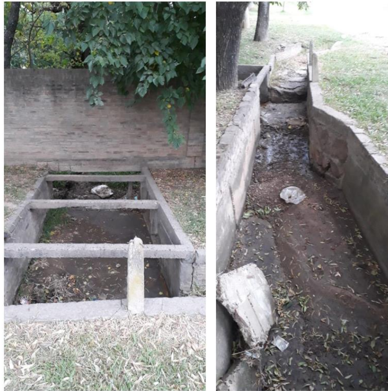
Ilustración 88 - Canal de sección rectangular en mampostería Fuente: Elaboración Propia
