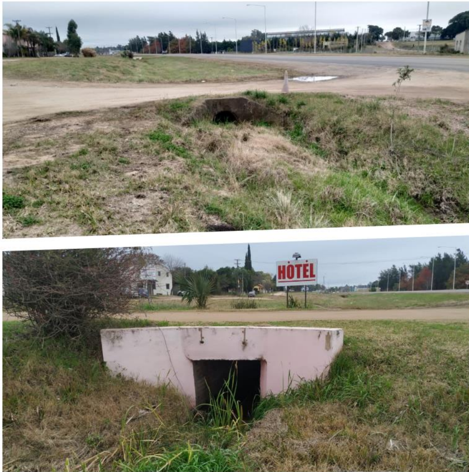
Ilustración 105 - Estructuras hidráulicas en 3 y 4 Fuente: Elaboración Propia
