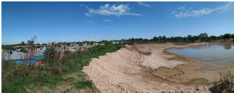
Ilustración 162 - Panorámica desnivel Piletas y barrio lindante
