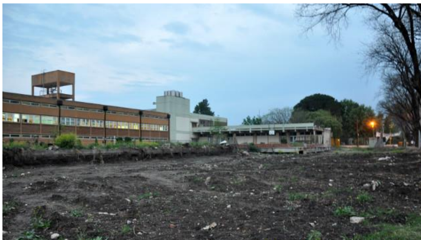
Ilustración 51 – Patio y piso deportivo (En Construcción) Fuente: Propia
