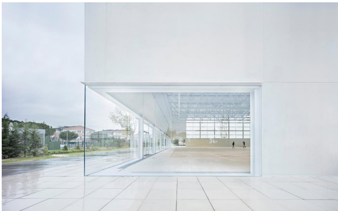
Ilustración 194 - Fachada Polideportivo Francisco de Vitoria con vidrio transparente
