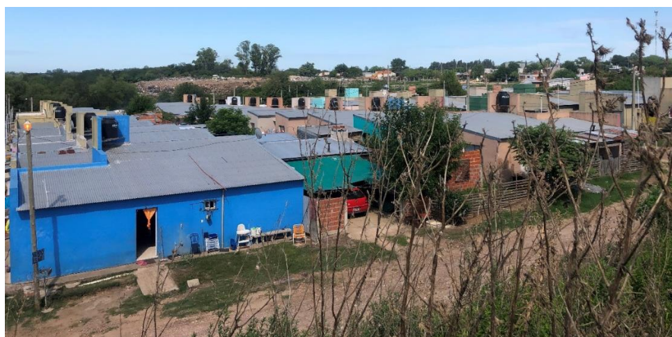
Ilustración 163 - Desnivel entre piletas de tratamiento y barrio lindante
