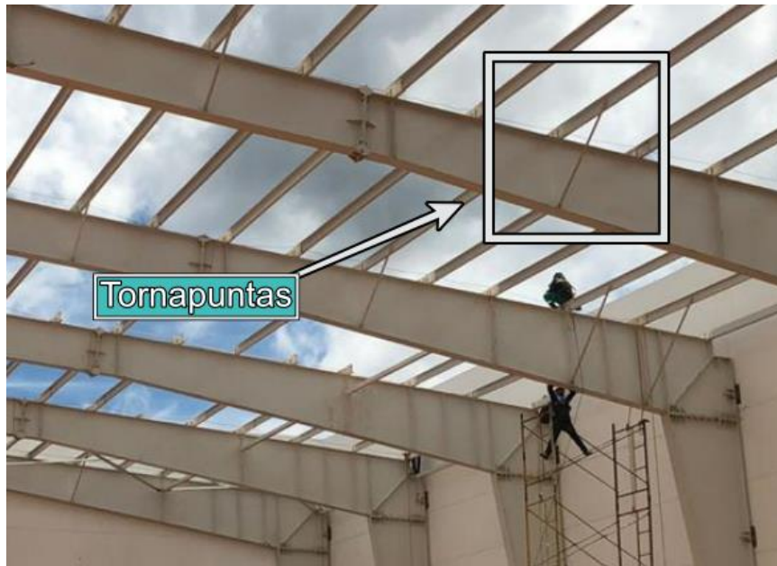
Ilustración 233 – Tornapuntas Fuente: Google Fotos
