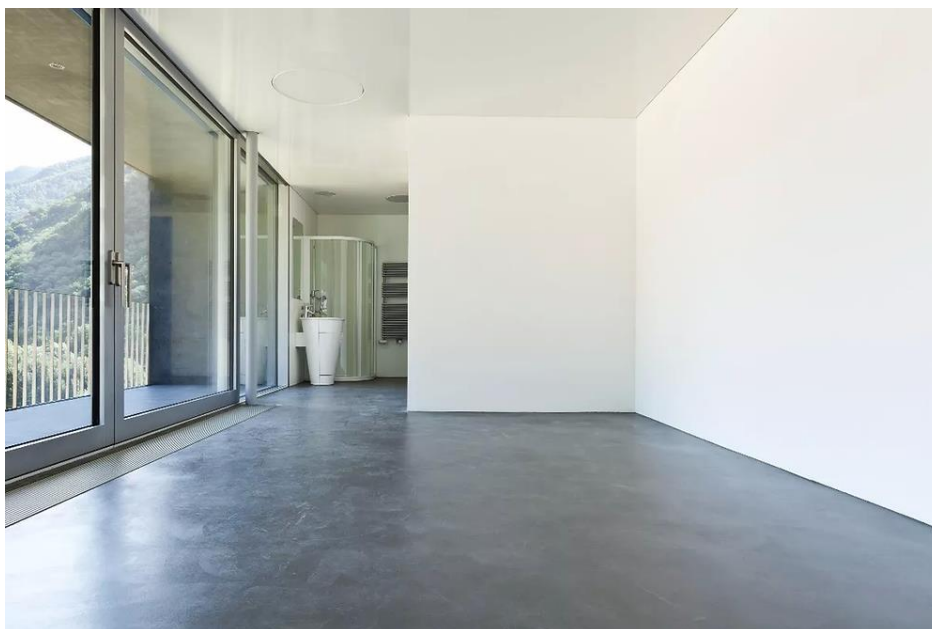
Ilustración 206 – Ejemplo piso de microcemento Fuente: https://www.somosrenova.com/
