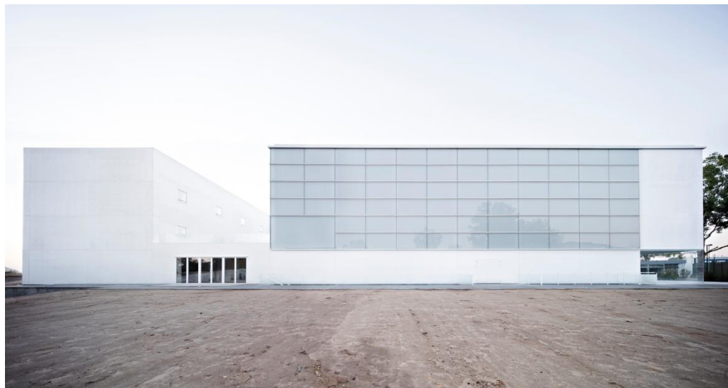
Ilustración 193 - Fachada Polideportivo Francisco de Vitoria vidrio translúcido y panel GCR
