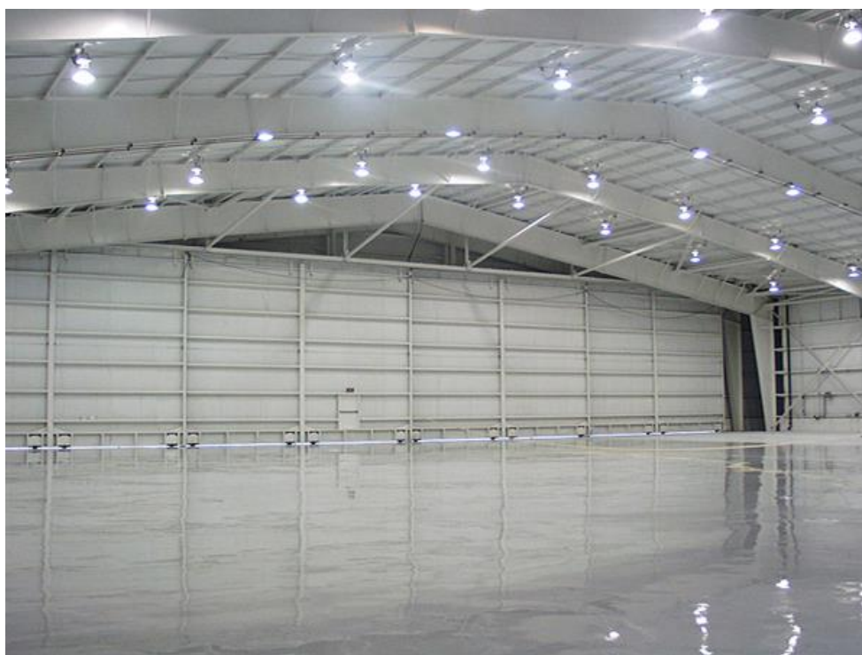
Ilustración 241 - Triangulaciones en hangar
