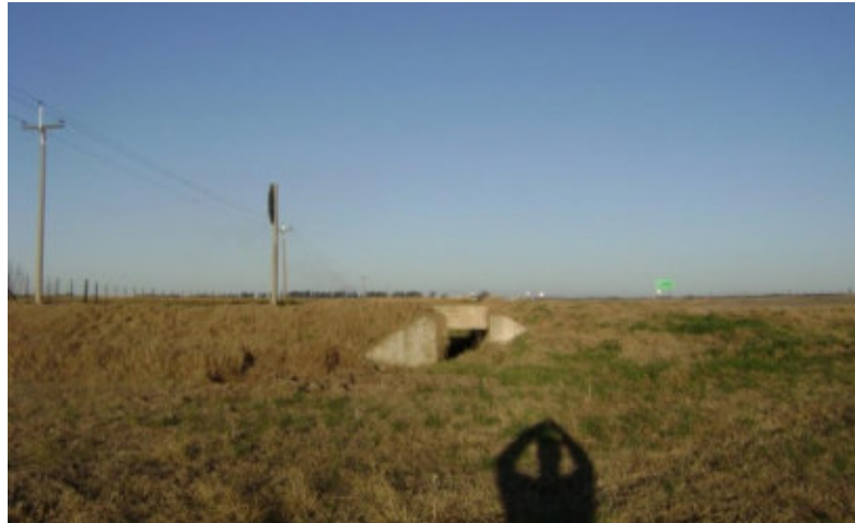
Alcantarilla en Intersección de Ruta Provincial N° 15 con Ruta Nacional N° 8
