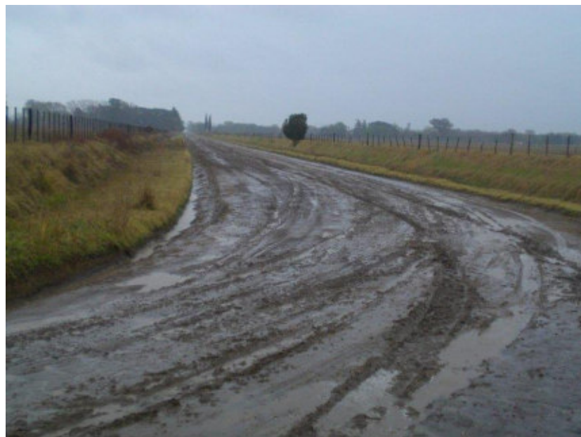
Tramo entre la R.N. N° 8 y la Localidad de San Francisco – jornada lluviosa
