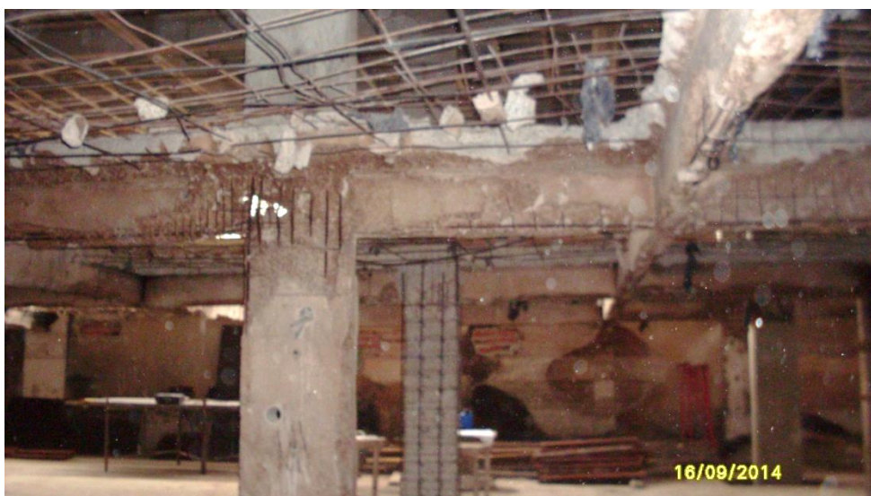
Figura 4.2.1. Laje demolida e refeita após incêndio.
