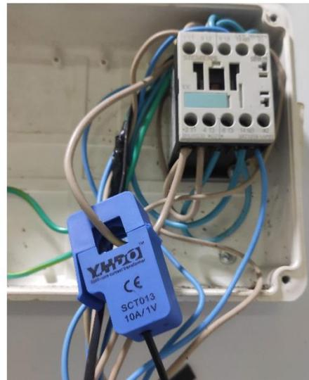
Figura 83 - Instalación Sensores Corriente
