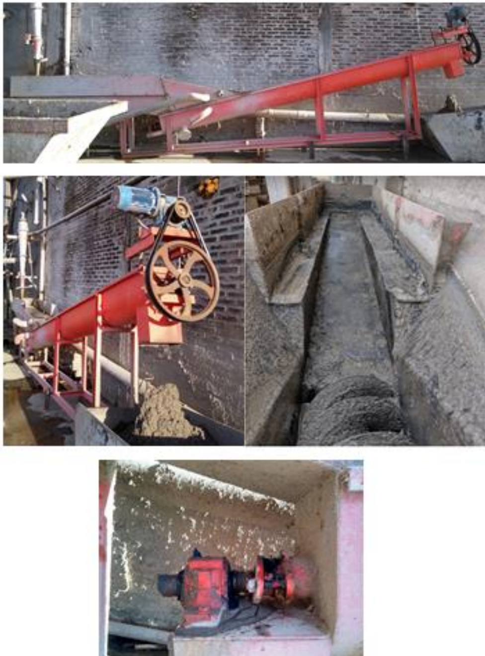
Imagen 2. Estado del sistema en la actualidad.
