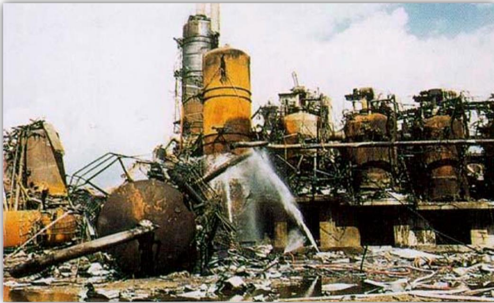
Monitores fijos arrojando agua para enfriamiento de tanques, días después de la explosión. Fuente: http://inspecaoequipto.blogspot.com/2013/06/caso-20-as-falhas-de-flixborough-1974
