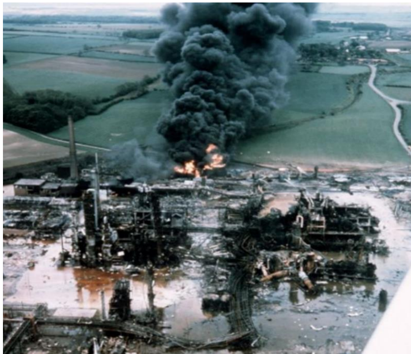
Imagen del predio de la planta de caprolactama, con los daños a la vista. Fuente: La prevención de accidentes graves en las operaciones de mantenimiento industrial
