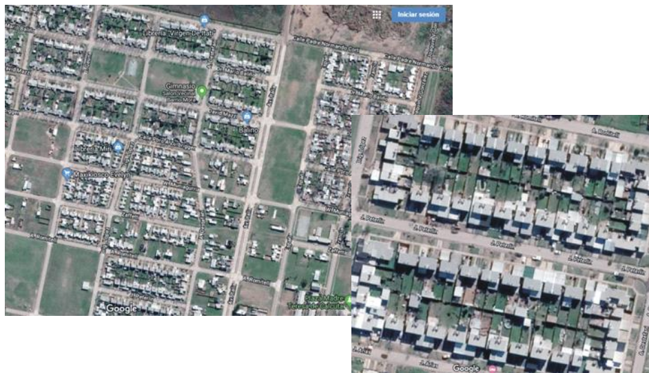
Figura N° 81- Imágenes del sector sur del barrio Moray Zazpe. Fuente: Google Maps 2.017
