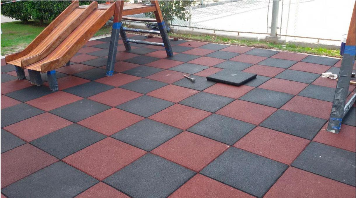
Figura 5.46 - Pisos caucho reciclado.
