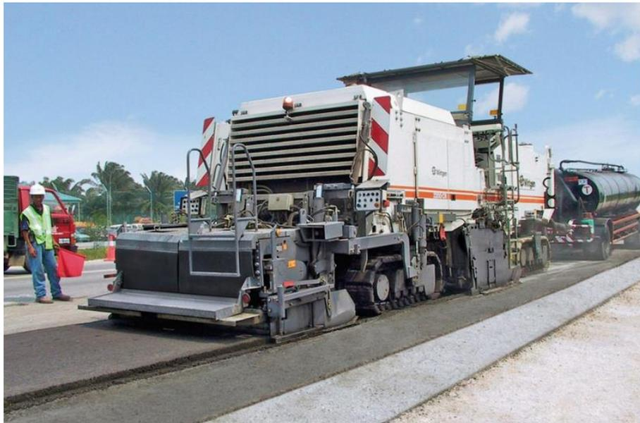
Figura 5.79 - Pavimento asfáltico reciclado.
