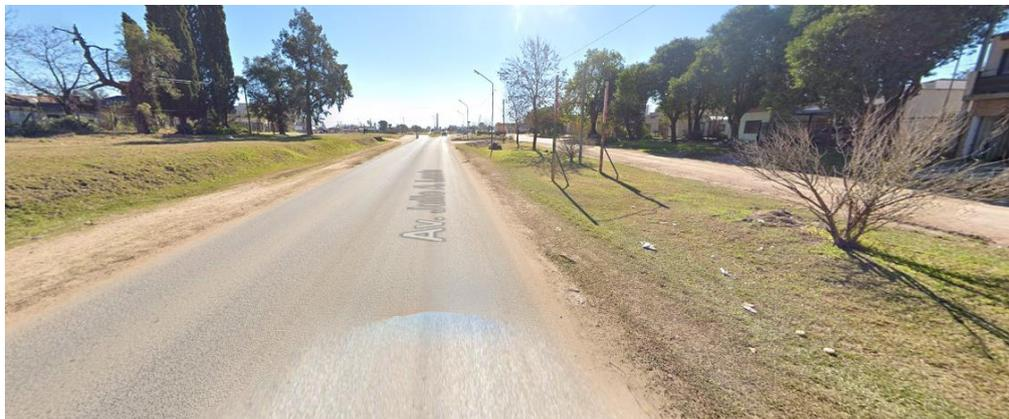
Figura 4.23 - Imagen Panorámica. Calzada de pavimento asfáltico de 7m de ancho y banquetas de 2.5m.
