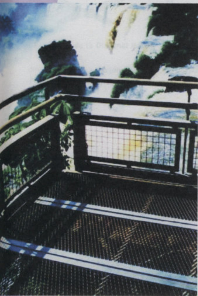
Uso de ExpanMetal en pasarela Cataratas del Iguazú - Misiones (Modelo 500.50-16 Kg/m 2 )
