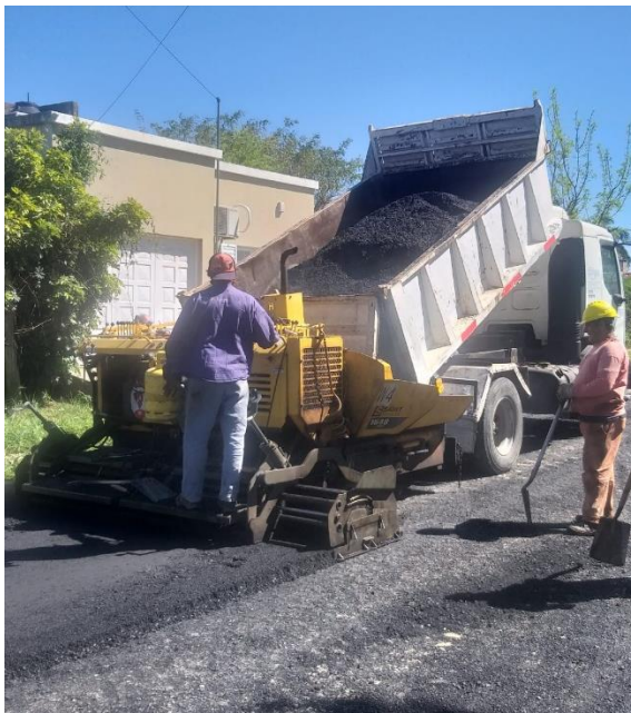
Volcado de Asfalto
