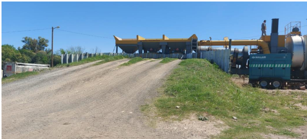
RAMPA PARA ARIDOS
