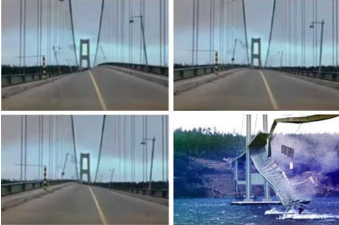
Fig. 8-1. – Respuesta dinámica y colapso del puente Tacoma Narrows, ver la ref. [19]
