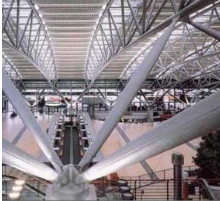
Fig.1-4. – Estructura reticulada – Aeropuerto de Kansai (Japón), vista interior
