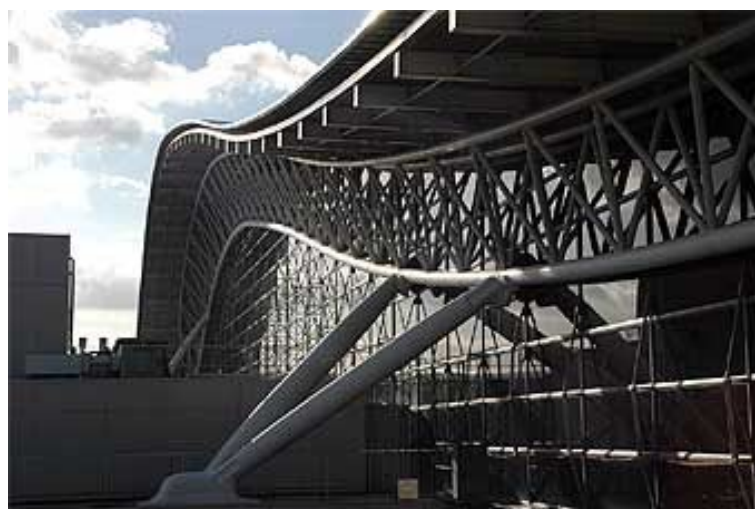
Fig. 1-3. – Estructura reticulada – Aeropuerto de Kansai (Japón), vista exterior
