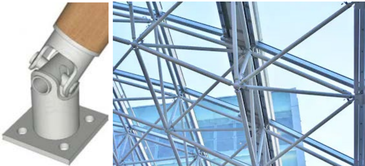
Fig. 2-7. – Ejemplos de articulaciones en estructuras de barras 2D-3D
