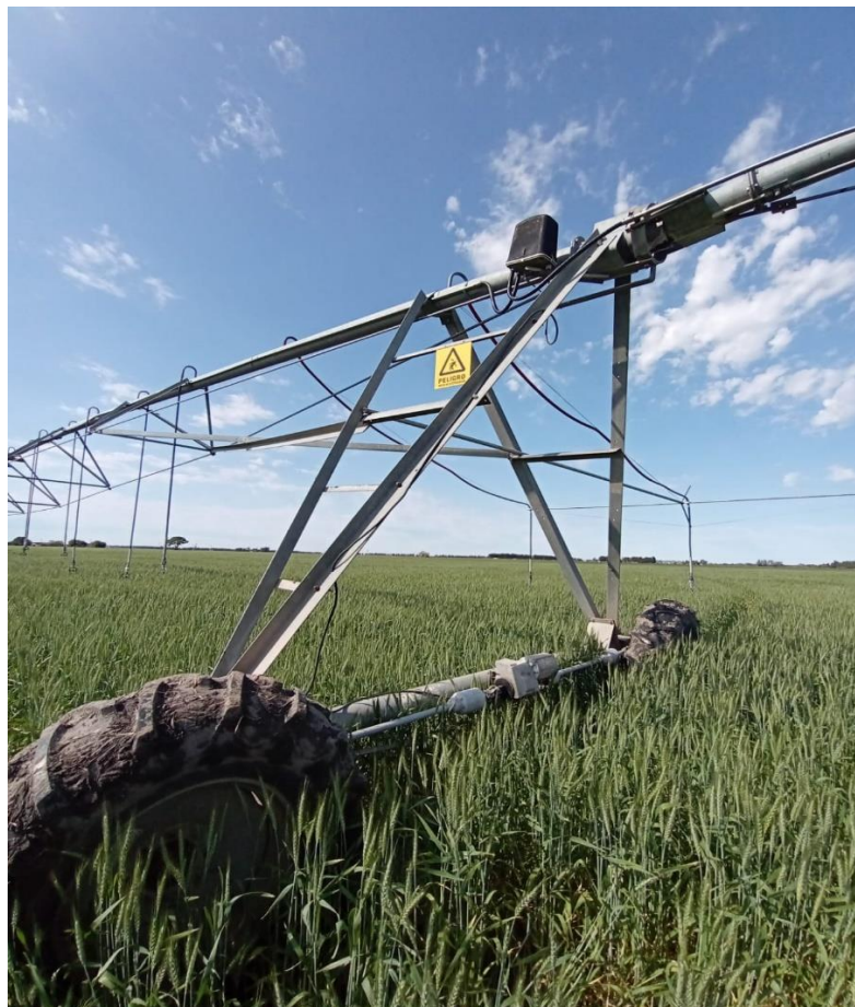
Figura N° 23: Torre motriz del pivote central.
