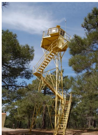
Figura 1. Punto de observación elevado para detección de incendios forestales.
