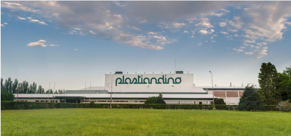
La planta industrial está ubicada sobre un predio de aproximadamente 5 hectáreas en zona industrial y posee una superficie cubierta de 6070 m<sup>2</sup> donde se alojan las maquinarias y oficinas administrativas. Cuenta con una subestación reductora de gas natural y subestación transformadora de electricidad propias.
