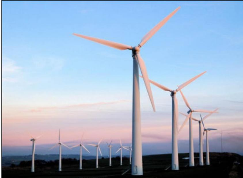
Figura 6 – Aerogeneradores de eje horizontal de tres palas.
