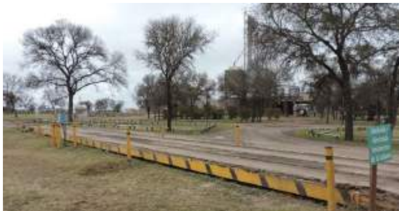
Fotografía 1.1– Báscula camionera actual – Elaboración propia.
