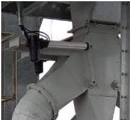
En este ejemplo la válvula VD1-B está cerrada.
