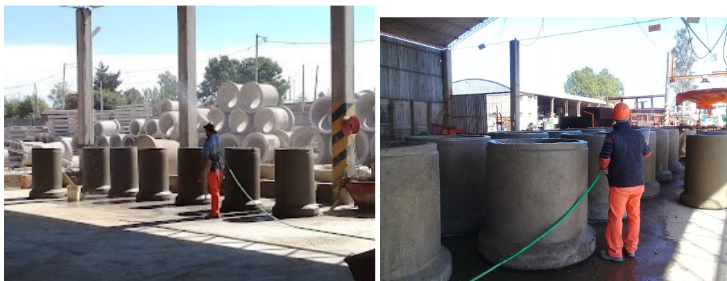
Figura 3.17: Humedecimiento de las superficies de los tubos para evitar la pérdida excesiva de humedad en el lugar de acopio.
