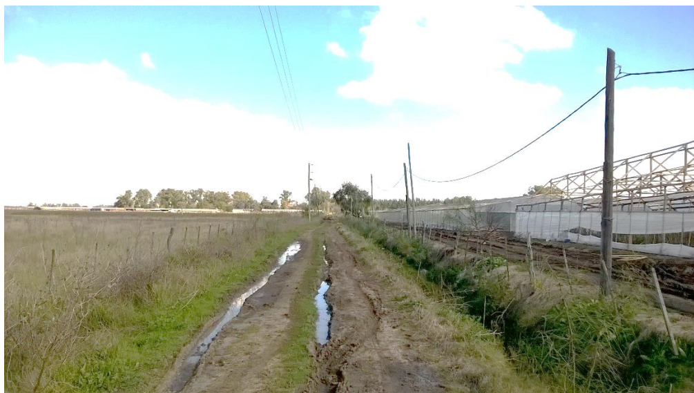
Profundización de cunetas de caminos vecinales para captar las canalizaciones internas
