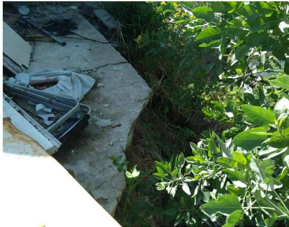
Figura 9.9 - Desmoronamiento en vivienda sobre margen canal.
