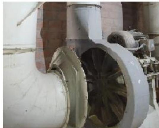
Fotografía 2.3 – Vista de las plaquitas de cerámica en el interior de la carcasa o voluta y vista de los álabes del ventilador centrífugo.
