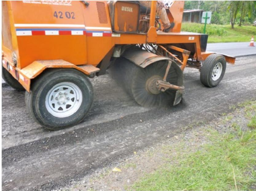
*Figura 5-21. Limpieza de la superficie a intervenir con barredora mecánica
