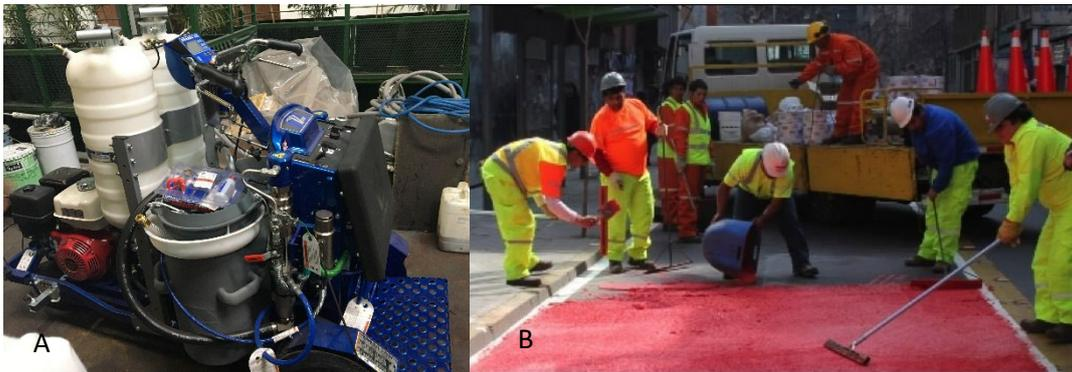
Figura 7-6. A: Aplicación con máquina. B: Aplicación Manual de Plástico en Frío
