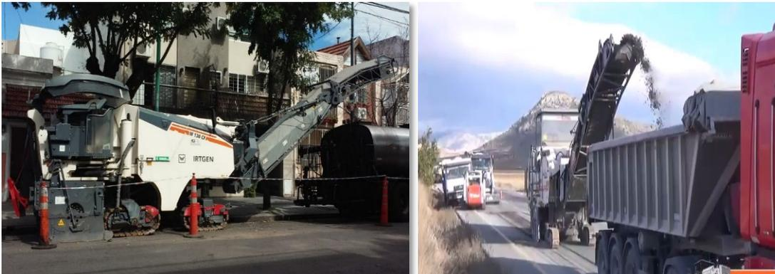
Figura 6-1. a la derecha se observa una maquina fresadora estacionada a pie de obra, mientras que a la izquierda se observa una maquinara en el proceso de fresado, generando la carga del material sobre el camión
