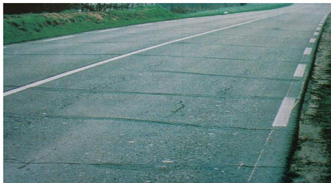
*Figura 2-9. Fisuración por reflejo de fisuras*
