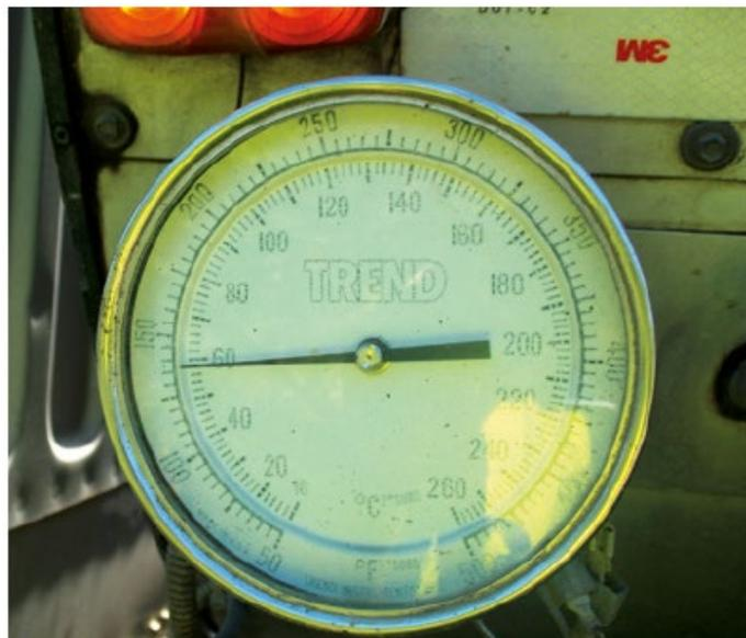
*Figura 5-20. Termómetro para verificar temperatura de almacenamiento y aplicación de la emulsión*
