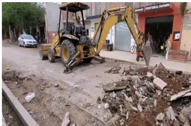
*Figura 6-3. Demolición de la carpeta asfáltica*
