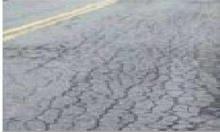
Figura 6-5. Figuración y desprendimiento
