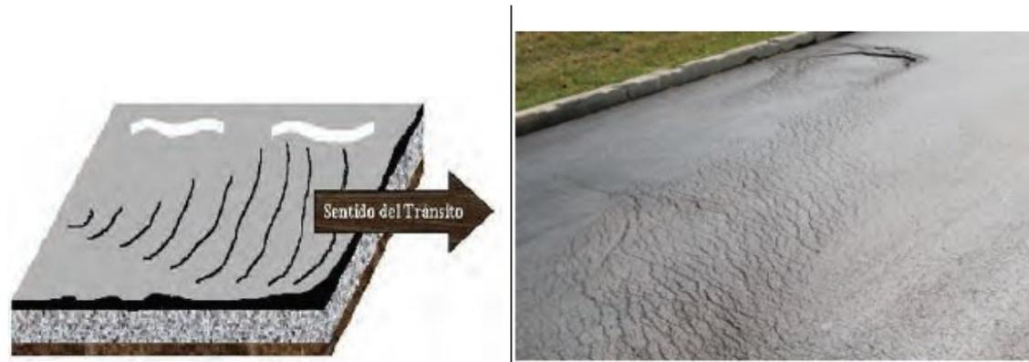
Figura 5-2. Falla del tipo “sholving” o corrimiento
