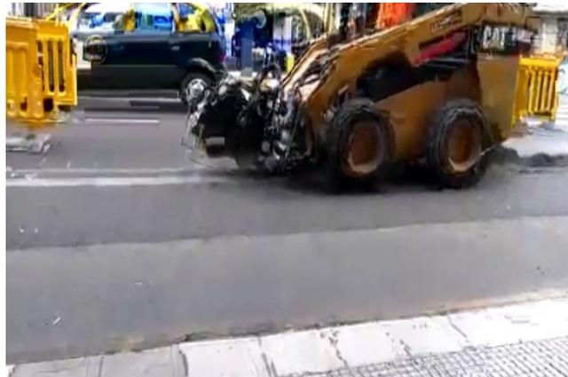
*Figura 6-2. Mini cargadora con accesorio fresadora*
