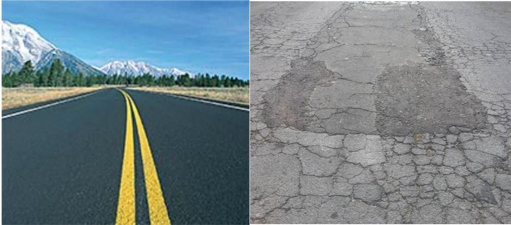
Figura 1-5. Estado del pavimento muy bueno (izq.) y muy malo (der.)
