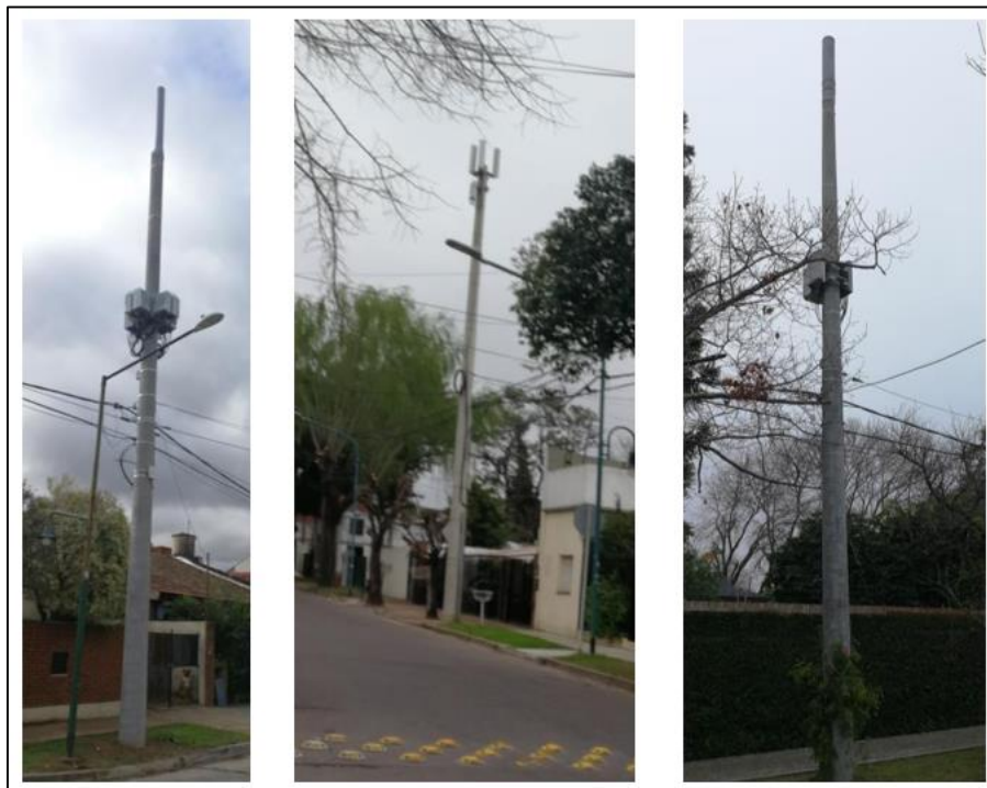
Figura 26 Implantaciones de sitios tipo WICAPS. Fuente: Ufinet
