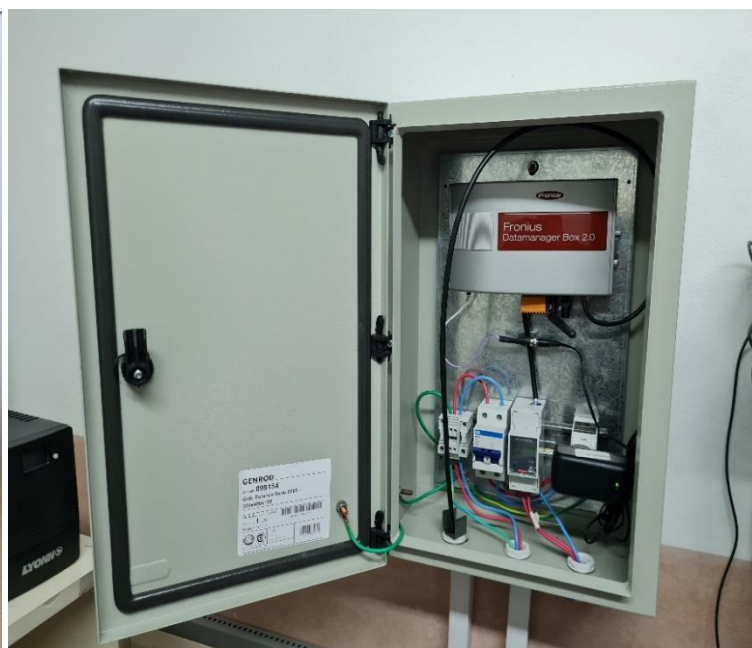
Figura 3b: Tablero para Datamanager
