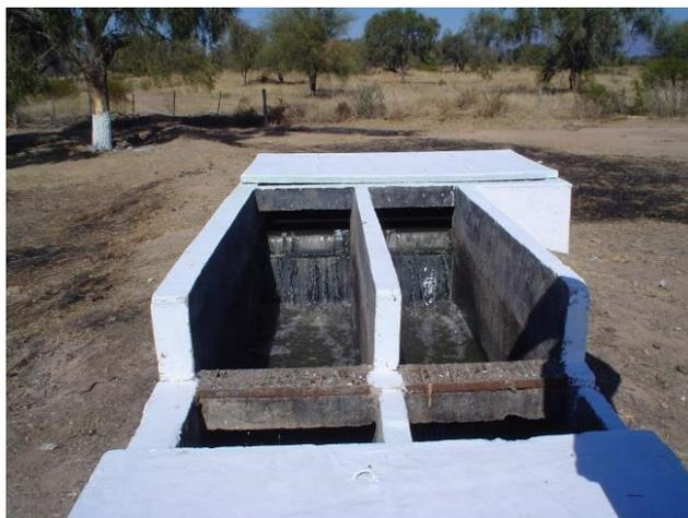
*Figura 5. Cámara de rejas planta existente.*
