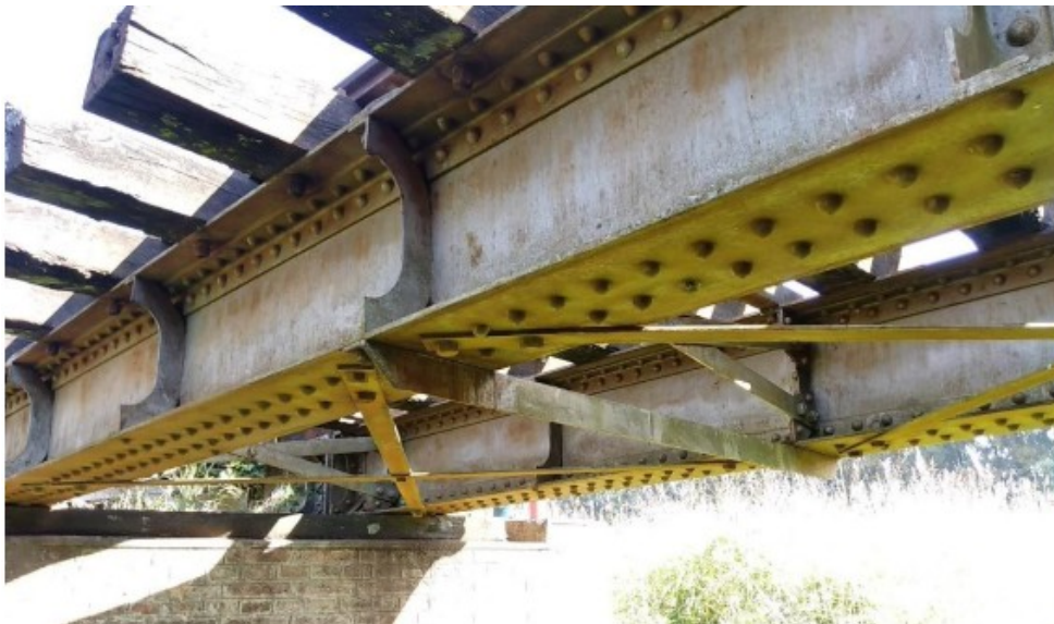
Fig. 4 – Vista inferior y detalle de vigas armadas y arriostramientos
