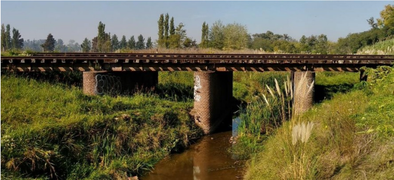
Fig.3 – Vista general del puente en estudio
