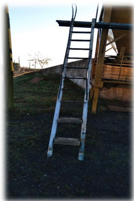
Escalera de acceso a las tolvas.
