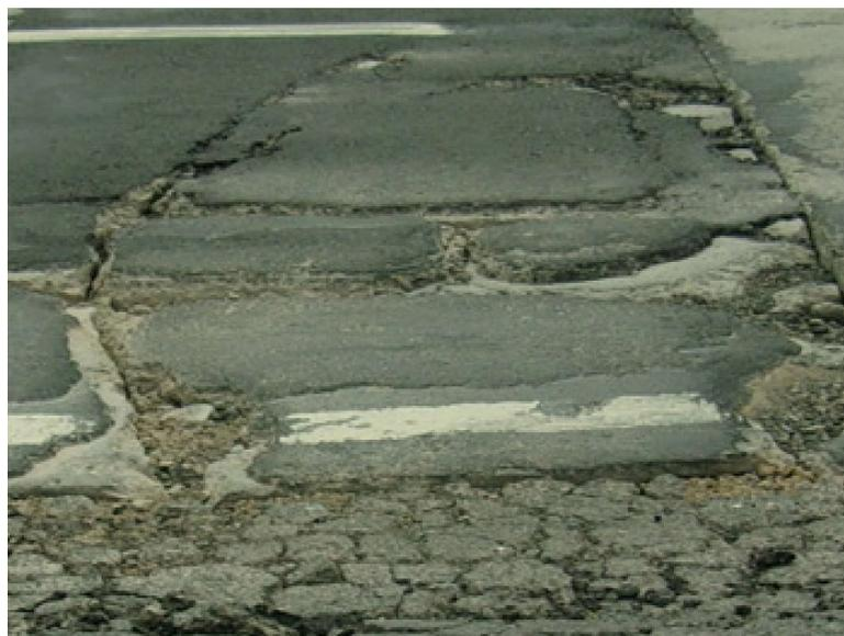
**Figura 4.** Resultado de la mala aplicación de mezcla asfáltica sobre pavimentos de hormigón.
