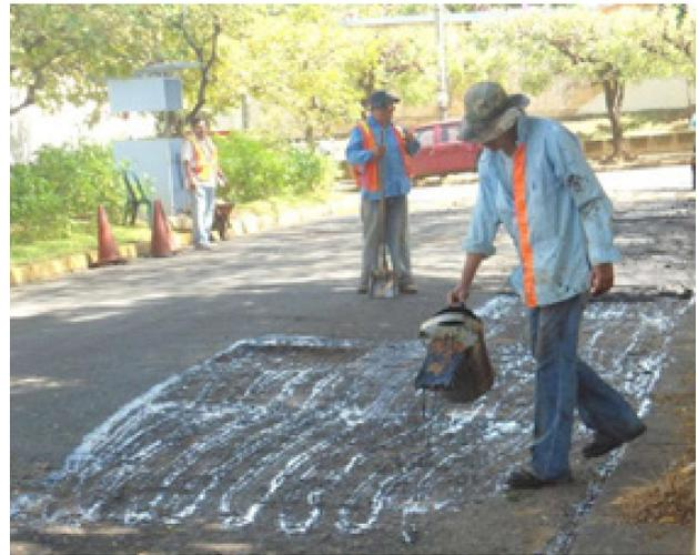
**Figura 3.** Inadecuado tomado de juntas (a) y aplicación de un riego de liga (b).
