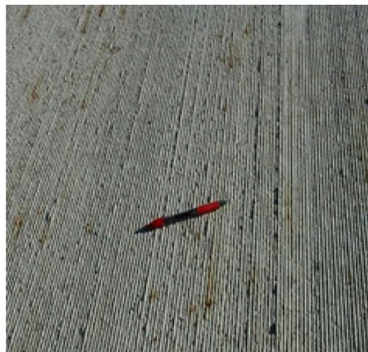
**Figura 6.** Equipo (a) y superficie terminada (b) por aplicación de diamond-grinding.
