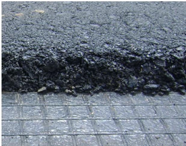
*Figura 7. Sistema antirreflejo de fisura mediante geosintético.*
