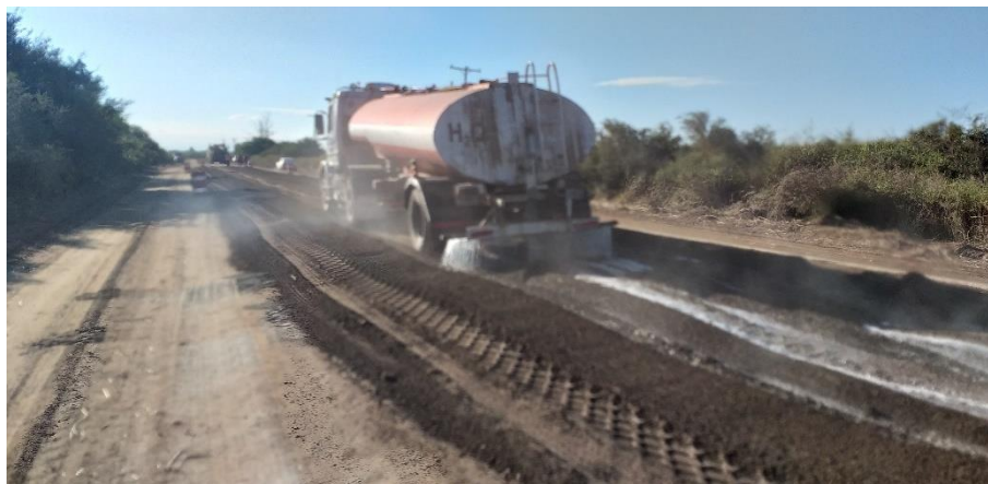
Figura 4. Distribución del estabilizante con el agua de riego. Fuente: elaboración propia
