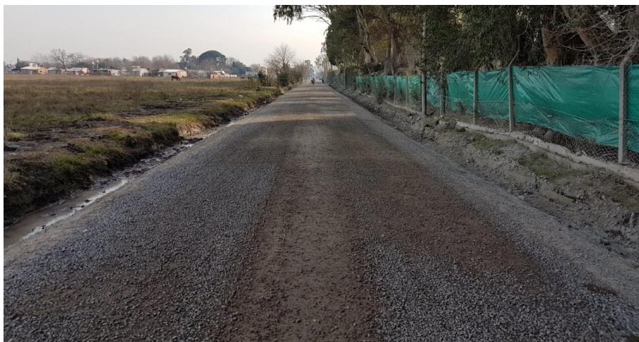
Figura 12. Obra con piedra partida distribuida superficialmente, recién terminada en junio de 2019. Fuente: elaboración propia
