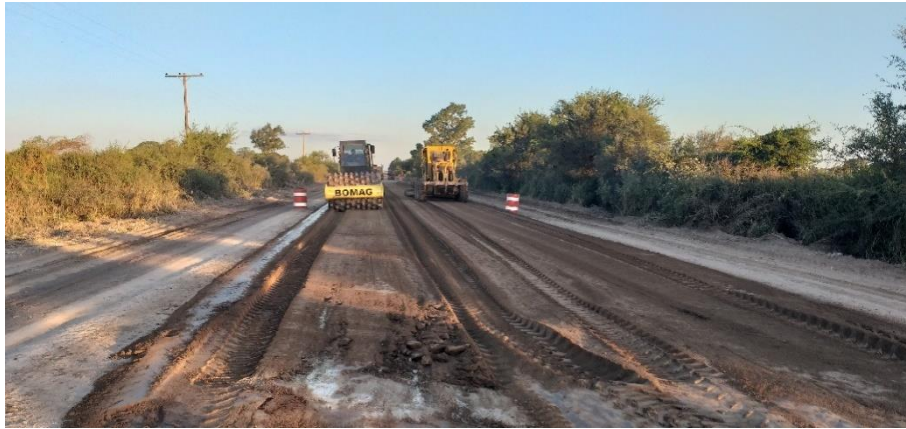
Figura 6. Distribución superficial con motoniveladora y primera etapa de compactación con rodillo pata de cabra. Fuente: elaboración propia
