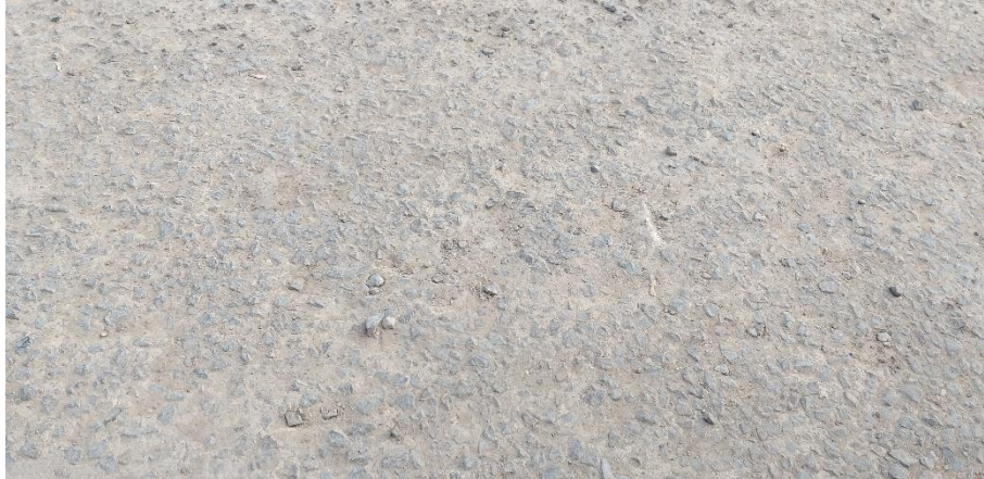
Figura 14. Hincado del agregado a 2 años de operación. Fuente: elaboración propia
