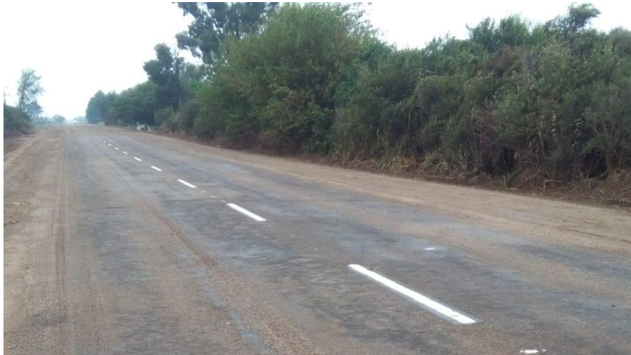
Figura 9. Terminación superficial de la capa de protección. Fuente: elaboración propia
