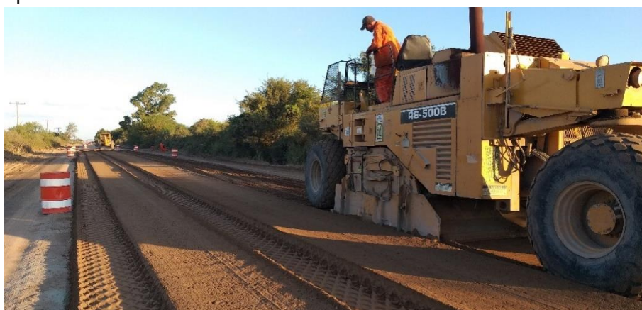
Figura 5. Mezclado mediante recicladora. Fuente: elaboración propia
