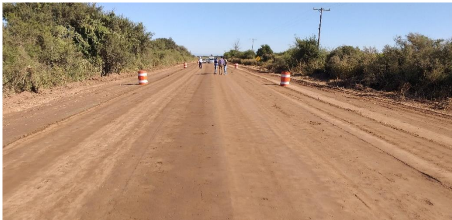
Figura 7. Adecuada lisura superficial de terminación. Fuente: elaboración propia
