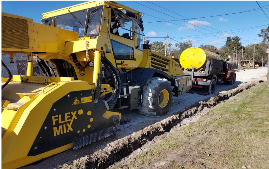
Figura 11. Mezclado mediante recicladora Fuente: elaboración propia
