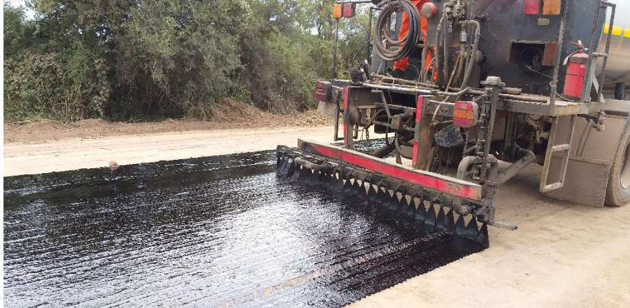
Figura 8. Aplicación de riego de imprimación de rotura lenta. Fuente: elaboración propia
