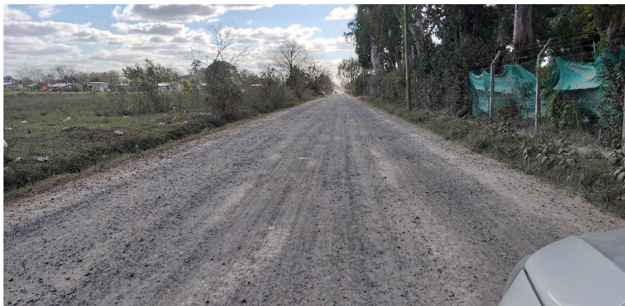
Figura 13. Obra con piedra partida distribuida superficialmente, en junio de 2021 después de 2 años de operación. Fuente: elaboración propia
