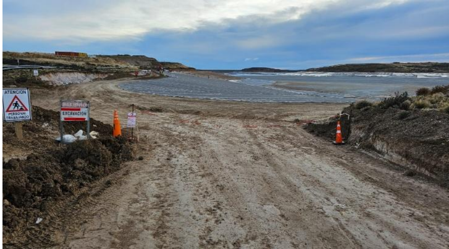
Figura 4: fotografía de los frentes de trabajos delimitados.
