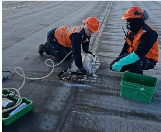
Figura 25: Trabajos de muestra de calidad.
