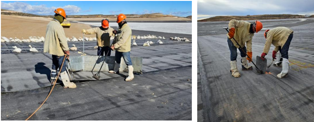
Figura 21: Trabajo de Soldadura.
