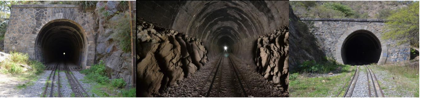
Gráfico N°19 – Imágenes de Ingreso desde Córdoba, interior y salida de Túnel, posterior a estación Cassaffousth. Fuente, web Tren Cordobés
