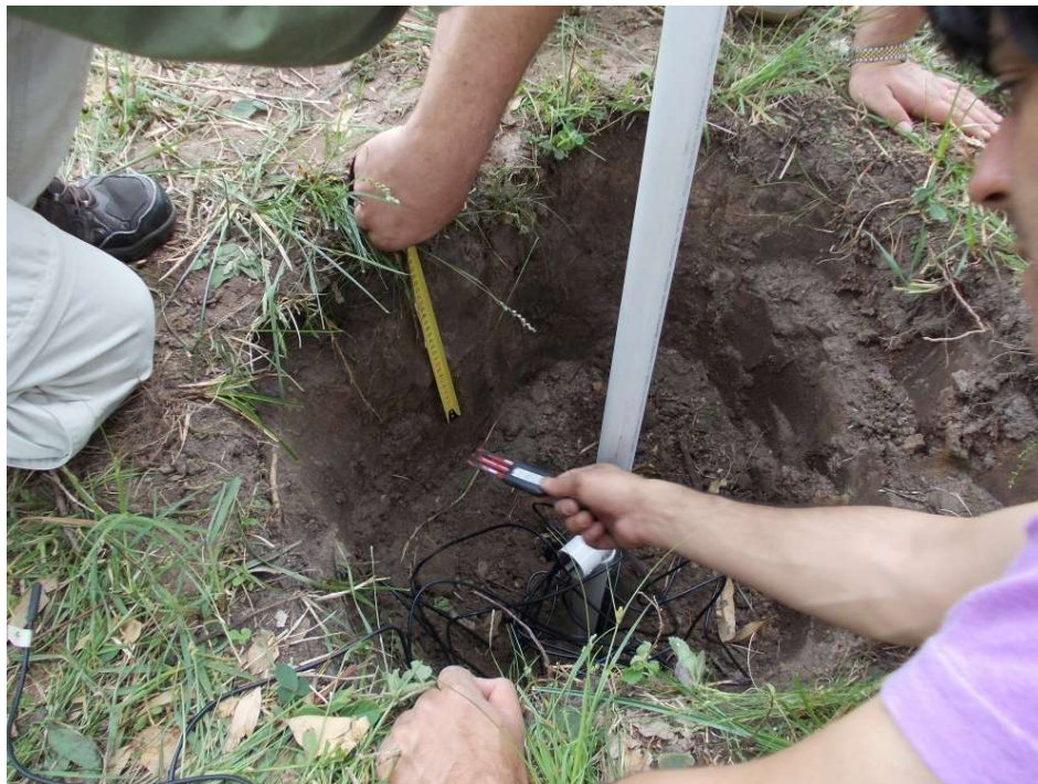
Figura 4.20. Instalación de los sensores 5TM.
