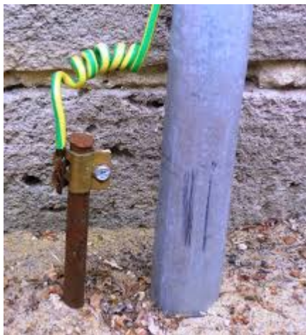
Imagen 8 – Ejemplo de Puesta a tierra
