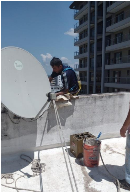
Figura 3. Anclaje sin cálculo de resistencia
