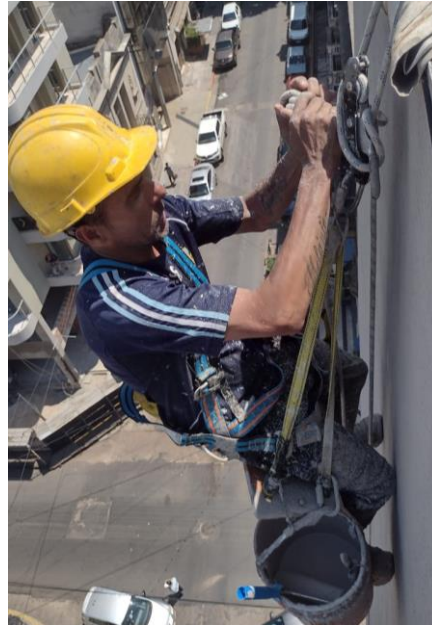
Figura 7. Sujeción de herramientas.
