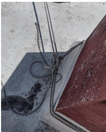
Figura 3. Anclaje sin cálculo de resistencia
