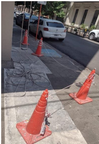
Figura 10. Protección colectiva. Señalización.
