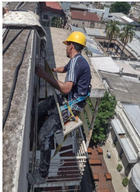
Figura 2. Sistema anticaídas sin anclaje independiente.
