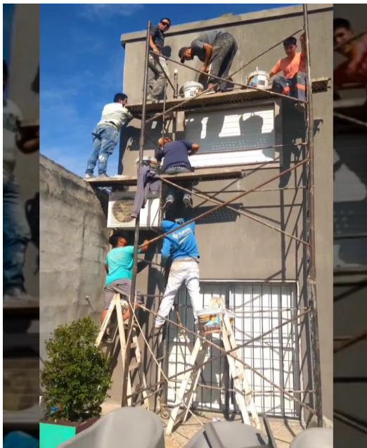
Figura 4. Pintores en andamio. Frontal.
